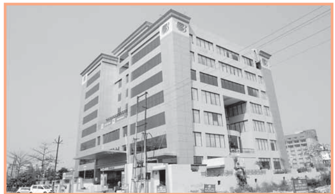
यू.पी.यू. अंचल, लखनऊ का नवनिर्मित भवन
